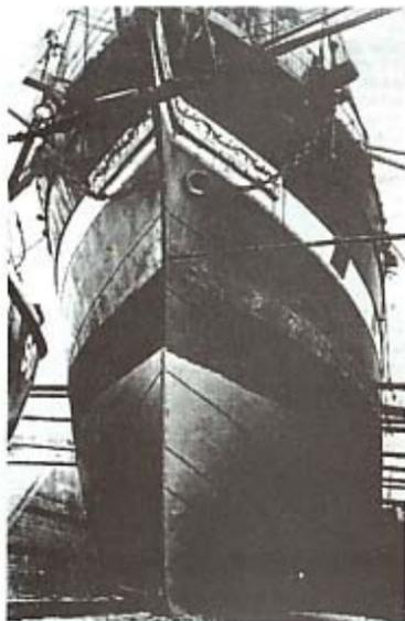
↓ Eine Vorderansicht des 1.447 tons großen eisernen Vollschiiffs RODNEY auf einem Trockendock. Gut zu erkennen sind die einzelnen Gänge der Eisenbeplattung.
